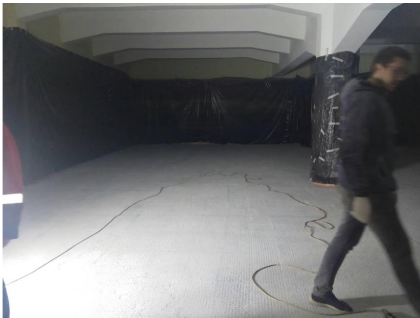
Рис. 2.1. Общий вид пола подвала
