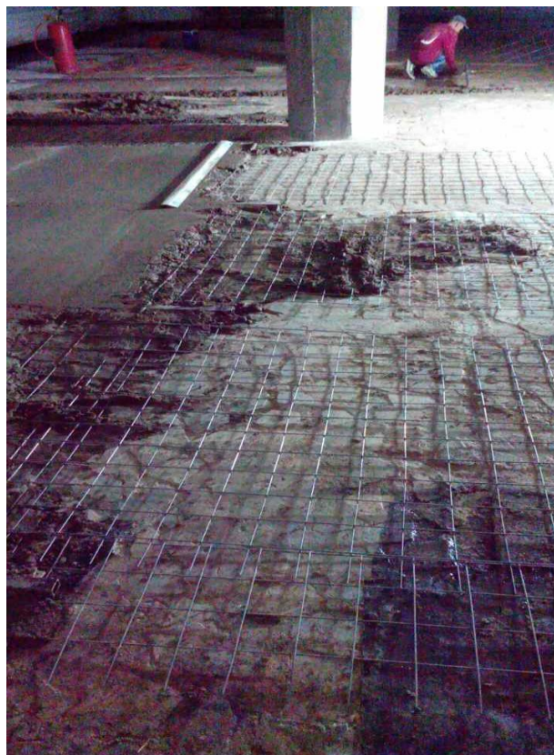
Фото .2.4. Армирование стяжки
