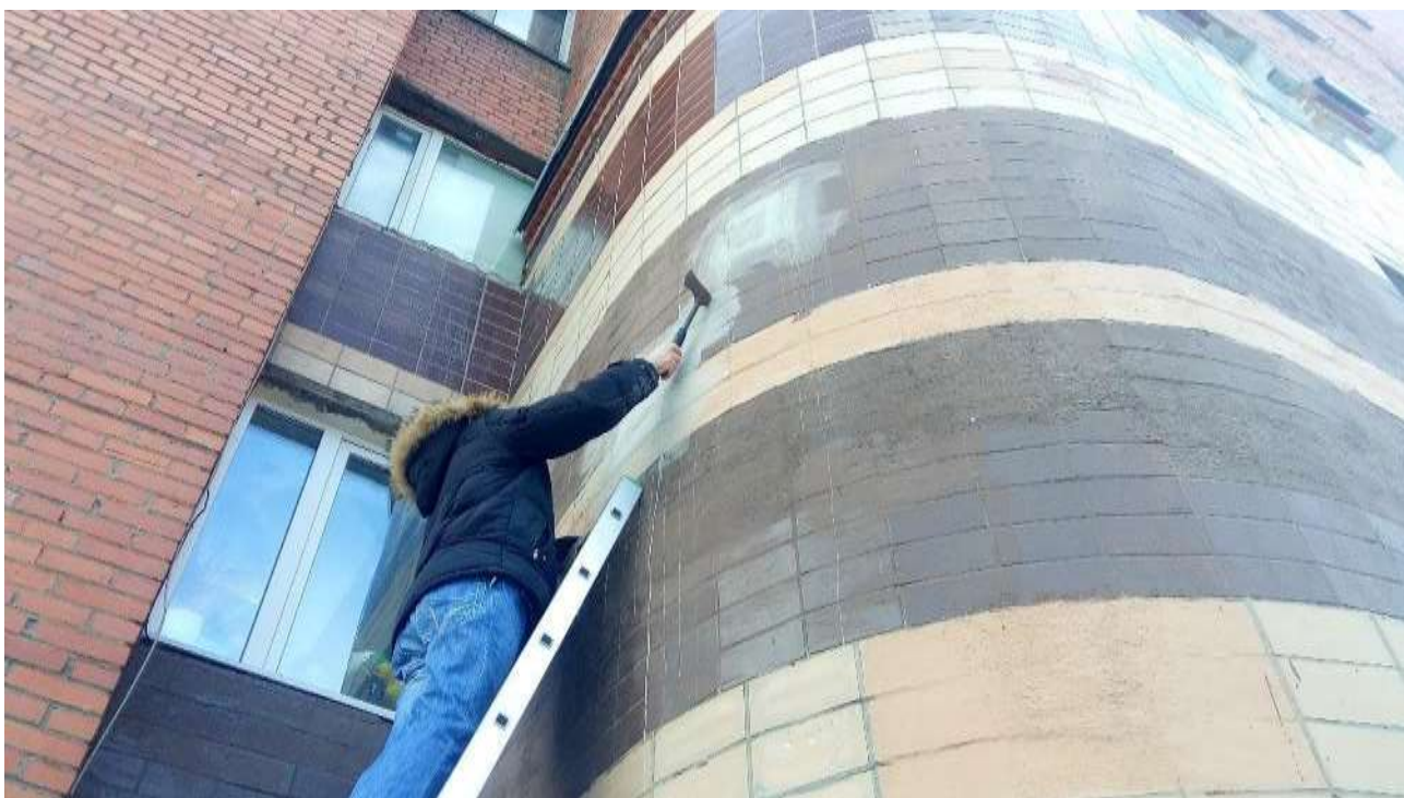
Фото 2. Простукивание облицовочной плитки
