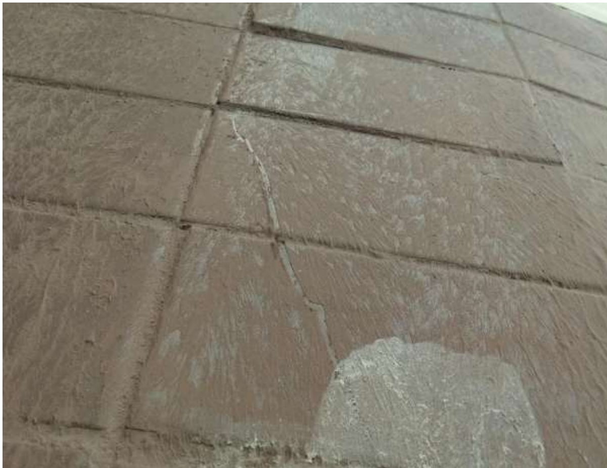
Фото3. Покрытие составом «Корунд»
