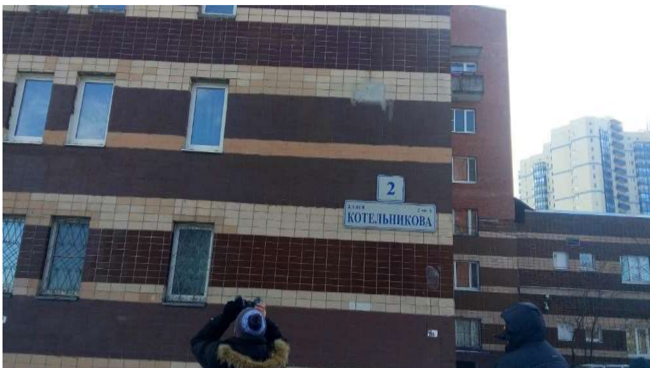
Фото .4. Освидетельствование фасада с помощью бинокля
