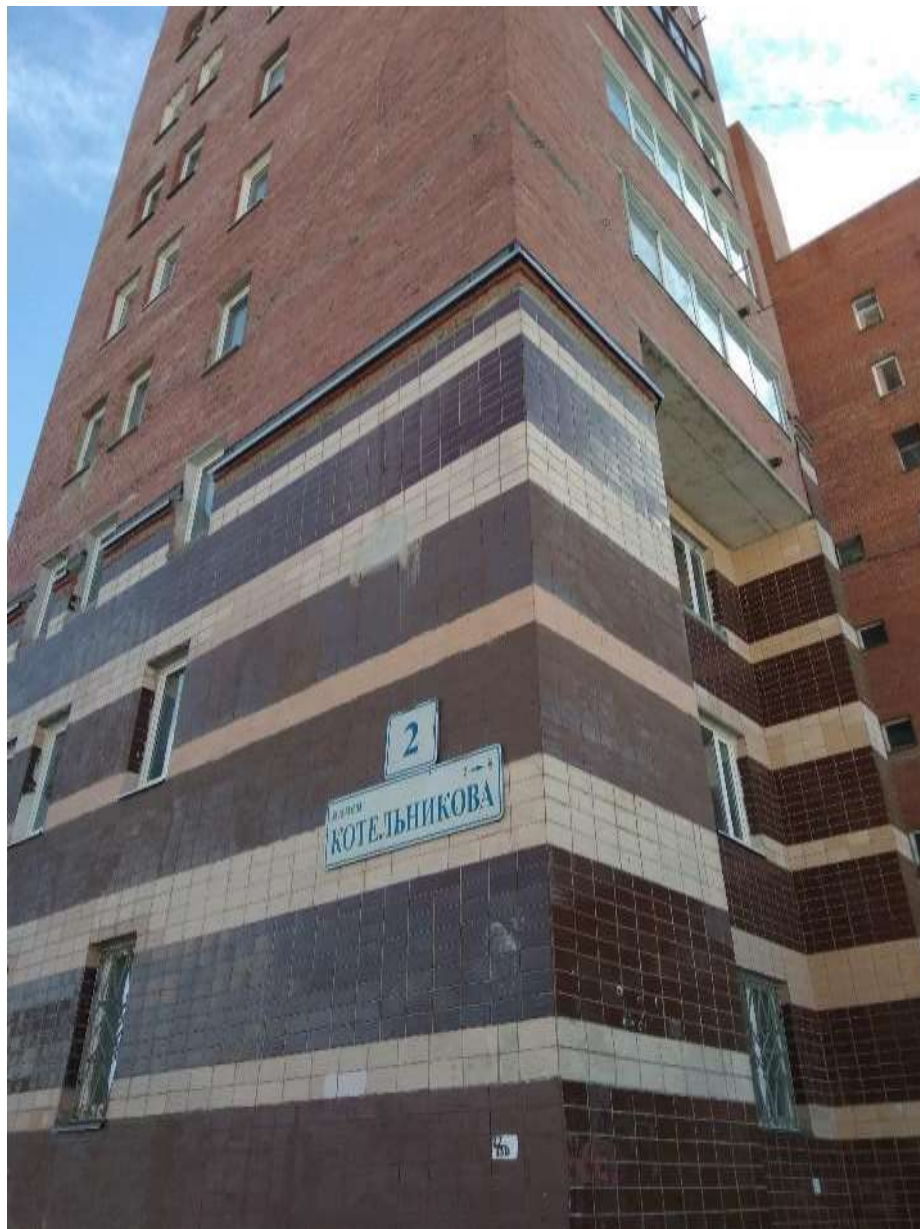
Рис. 2.1. Общий вид здания
