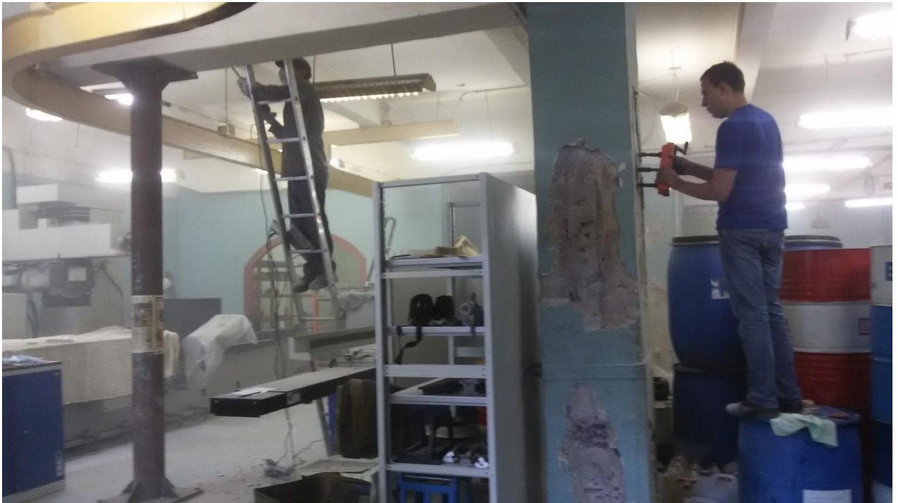
Фото П.3.5. Исследование бетона методом отрыва со скалыванием
