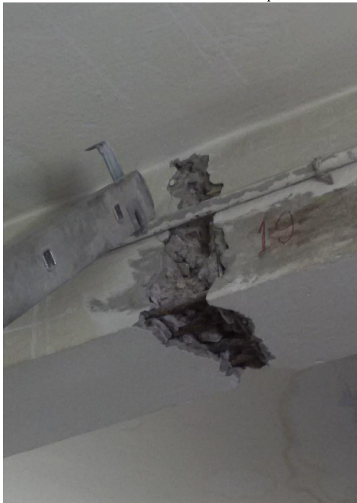
Фото П.3.6. Вскрытие армирования второстепенной балки
