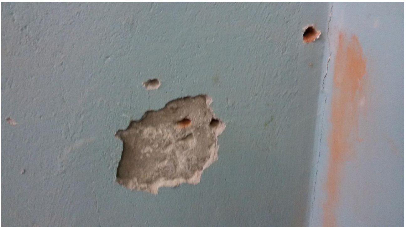
Фото П.3.10. Вскрытие штукатурного слоя стены для определения марки кирпича и раствора
