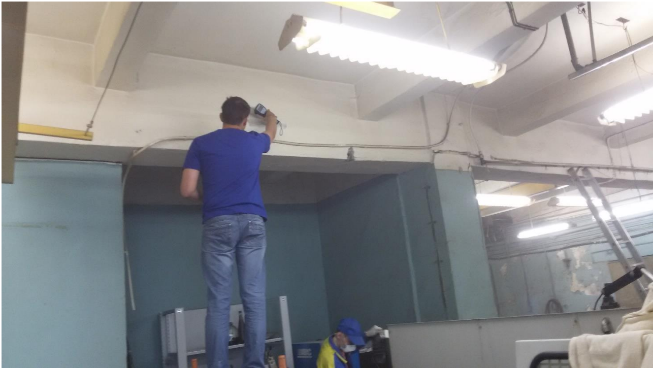
Фото П.3.3. Ультразвуковое исследование бетона
