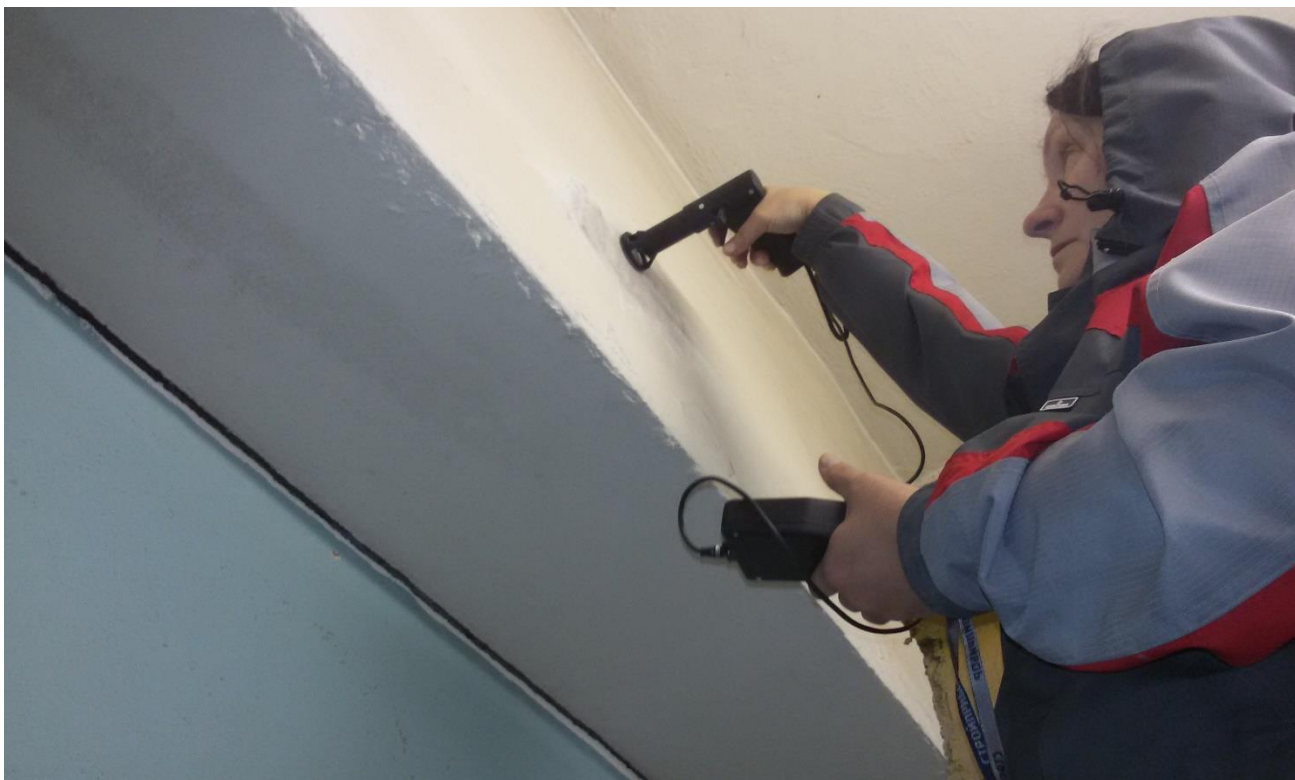
Фото П.3.4. Исследование бетона методом ударного отскока
