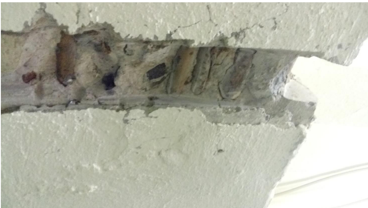
Фото П.3.8. Вскрытие арматуры главной балки
