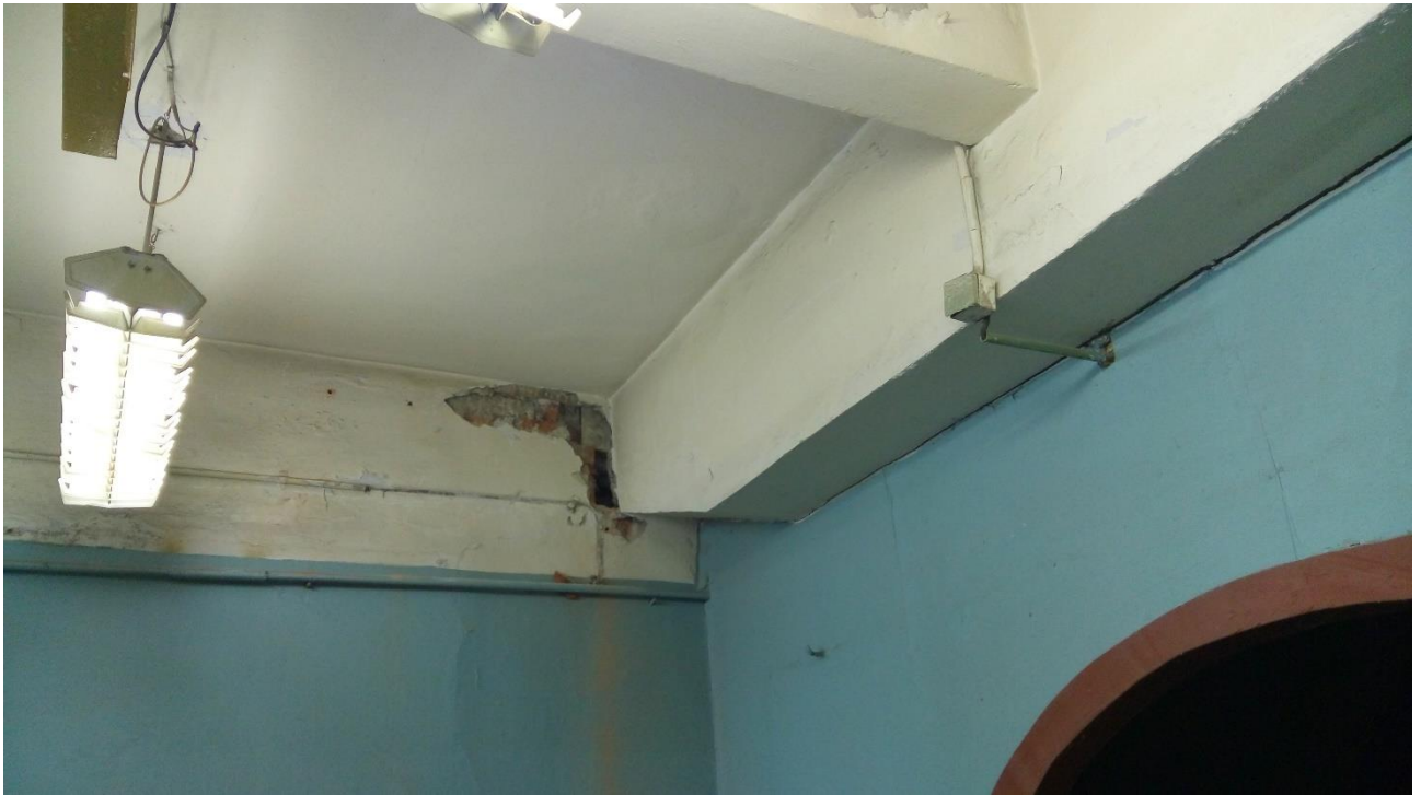
Фото П.3.9. Вскрытие участка опирания главной балки на стену
